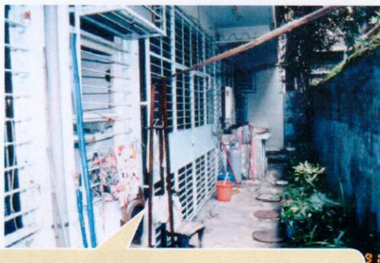
(十八)現場後面並未發現破壞侵入之跡象。
