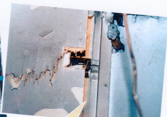
(二)現場唯一出入之木門由內上有拴鎖，經消防人員破門進入現場搶救而損壞。
