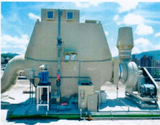
圖二十、本中心大樓頂之濕式廢氣處理系統
