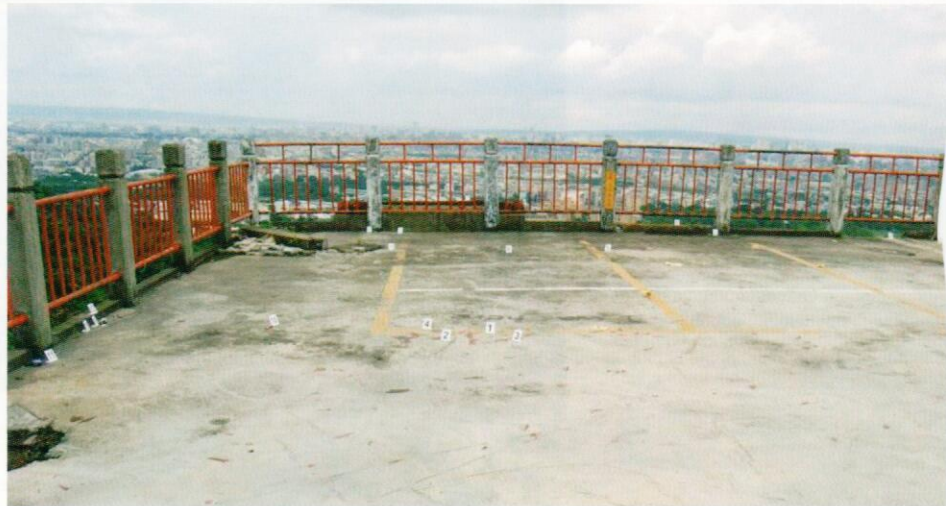
圖4、頂樓平臺情形，已標示跡證位置
