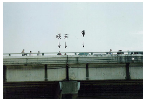
照片15、 證人王○雲在吊車上觀看橋面人車情形。
