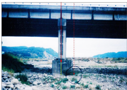
照片32、 P2 橋墩伸縮縫中心為量測基準點。
